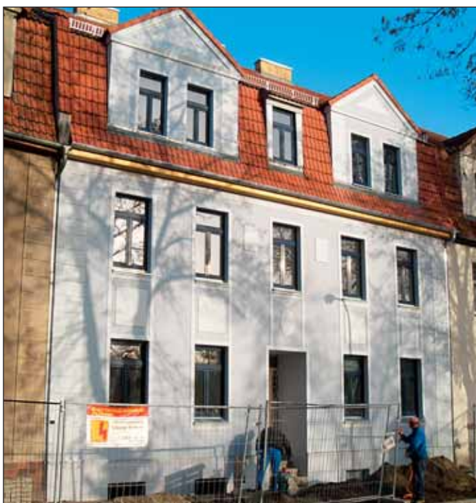
Das Gebäude Am langen Hacken 11 kurz vor der Fertigstellung
